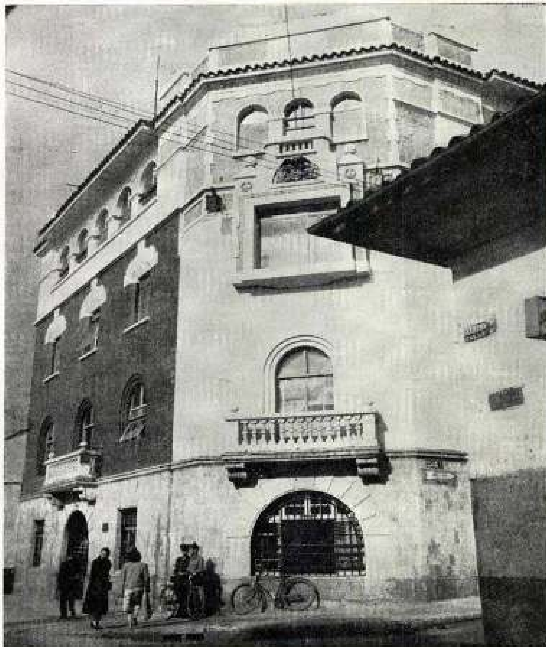
ESTACION IV DE POLICIA. — Situada en la esquina nordeste de la carrera 7ª con la calle 4ª, en Bogotá, tiene capacidad para 500 agentes y controla los servicios de vigilancia de los barrios Egipto, Girardot, Las Cruces, Los Lachos, Lourdes, El Rocio, Las Brisas y Urbanización Ramírez. De ella depende la Subestación de "El Guavio", con capacidad para 150 agentes.
