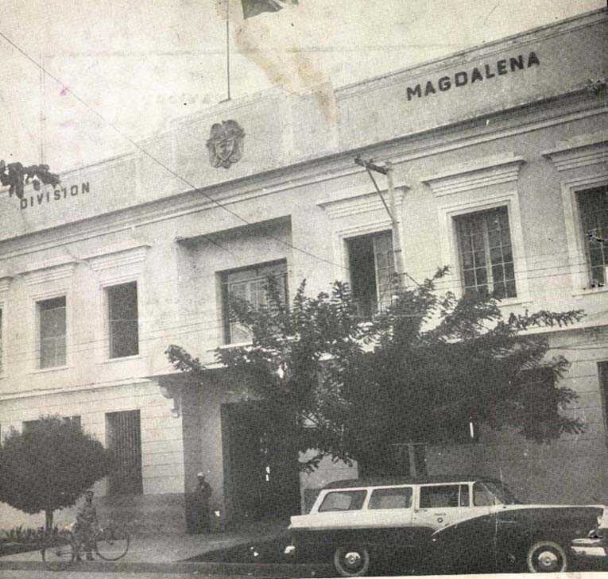
Edificio del Comando de la Unidad "Magdalena", en Santa Marta. Está ubicado en la calle 22 N° 1-79.
