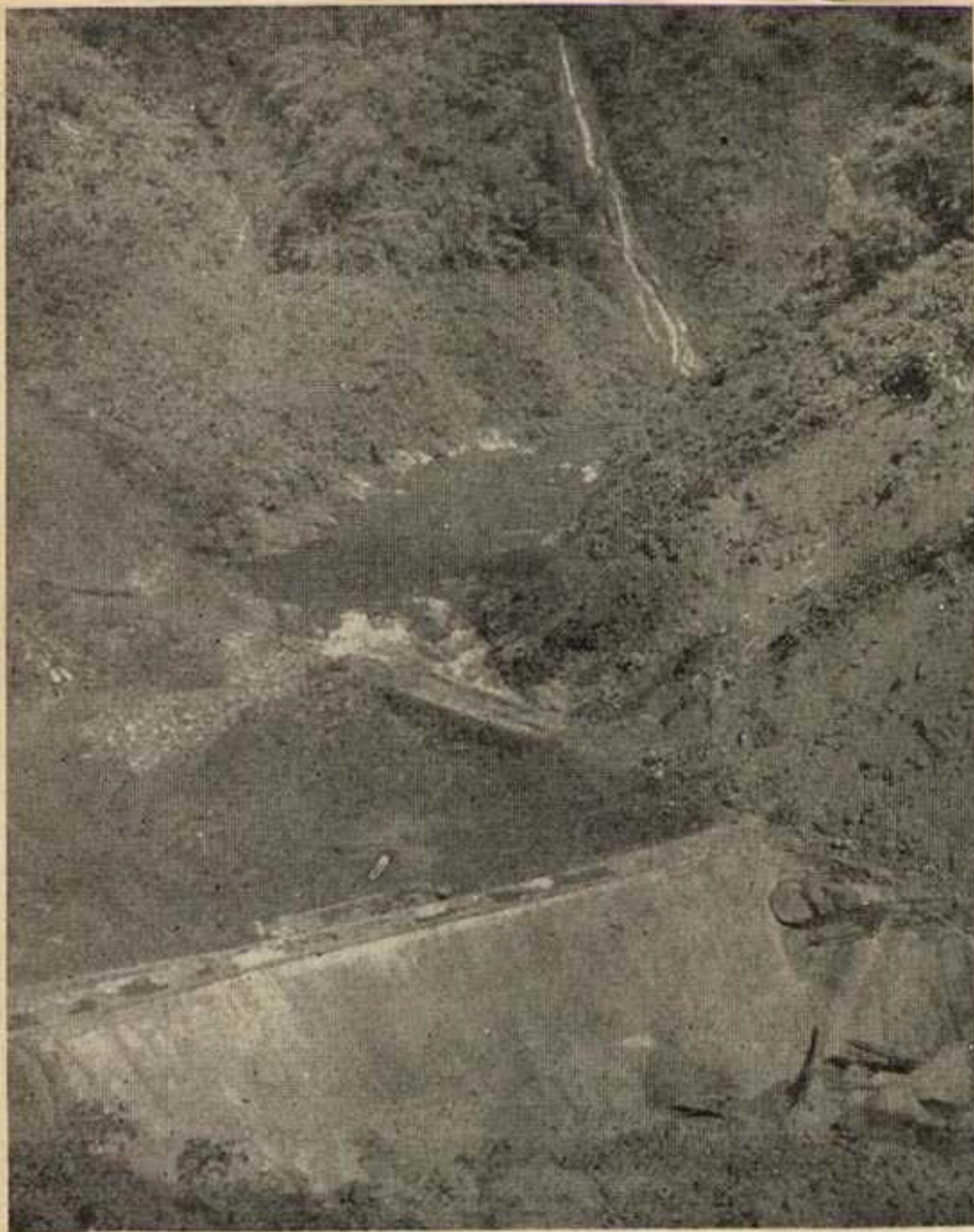
Panorámica de las obras que se están realizando para la Central Hidroeléctrica del Río Anchicayá, situadas a 89 kilómetros de la ciudad de Cali. En la gráfica se aprecian la ataguía y el túnel de desviación.
